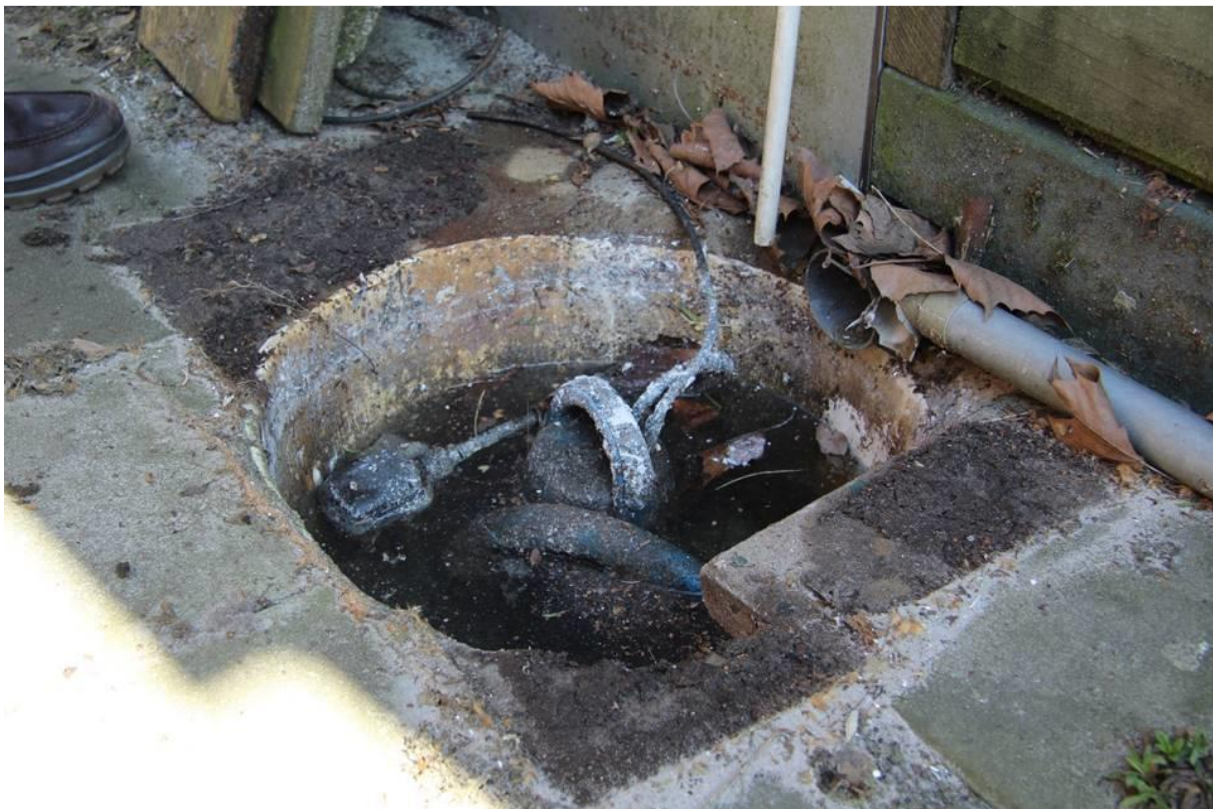
Figuur 3.4 Pompput in achterpad Jan Willen Frisostraat 22-24
